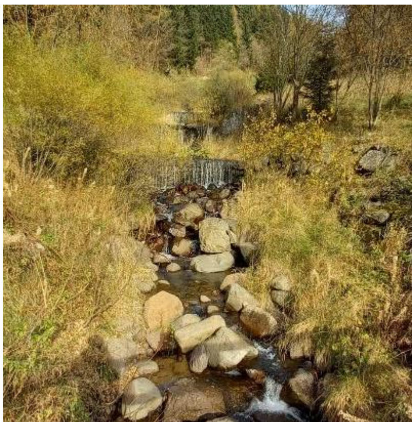
Figura 4.6: F3 – briglia di consolidamento lungo il tratto sistemato.
