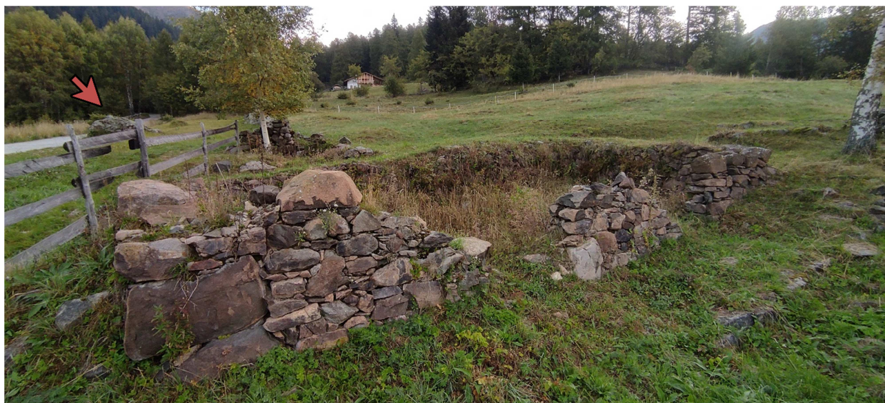
foto della situazione attuale
