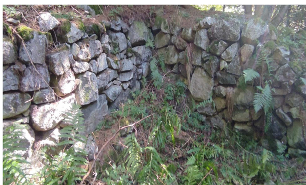
Vista ravvicinata della muratura a monte
