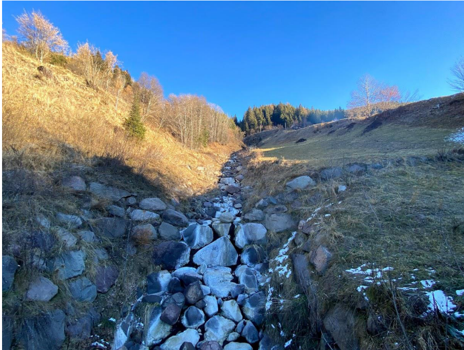
Fig. 15: vista verso monte dal primo attraversamento (progressiva 85 ml). Si osservano le opere eseguite dalla PAT, costituite da scogliere in massi ciclopici.
