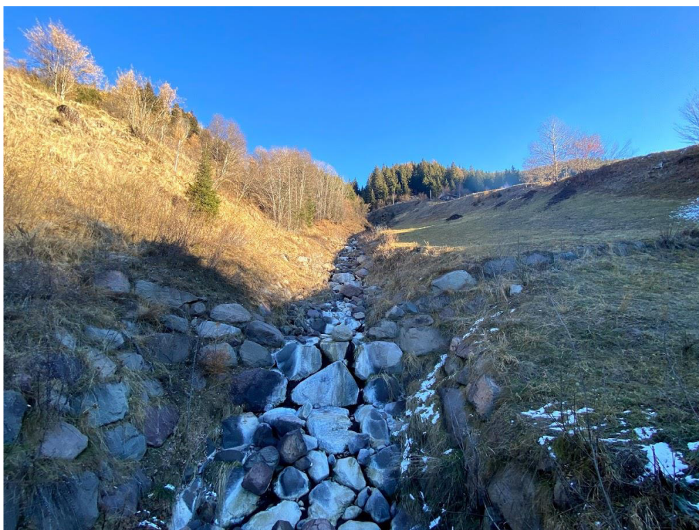
Fig. 38: vista verso monte primo attraversamento (progressiva 85 ml). Si osservano le opere eseguite dalla PAT, costituite da scogliere in massi ciclopici. L'eventuale colata verrebbe contenuta dalle ampie e ripide sponde del rio.
