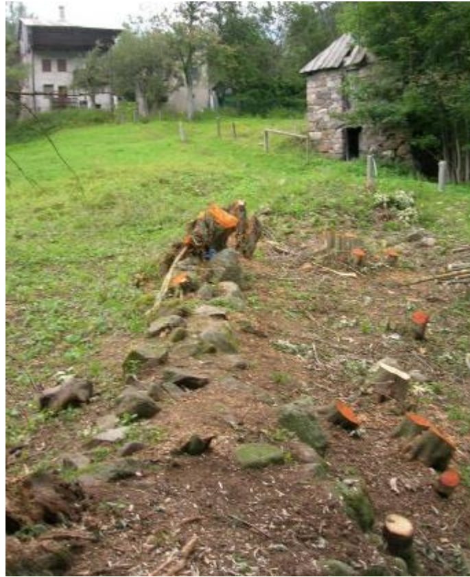
Figura 2.3: Particolare vecchio canale (rilievo 2010)
