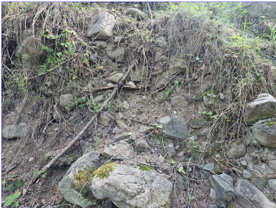
Figura 4.1-2: vista sul deposito sciolto che caratterizza l'area di intervento.
