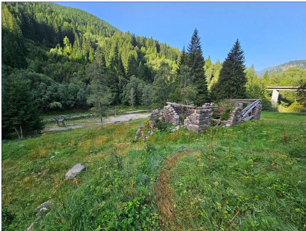
Figura 2-3: vista da nord-est dell'area di intervento (in primo piano i ruderi della segheria).
