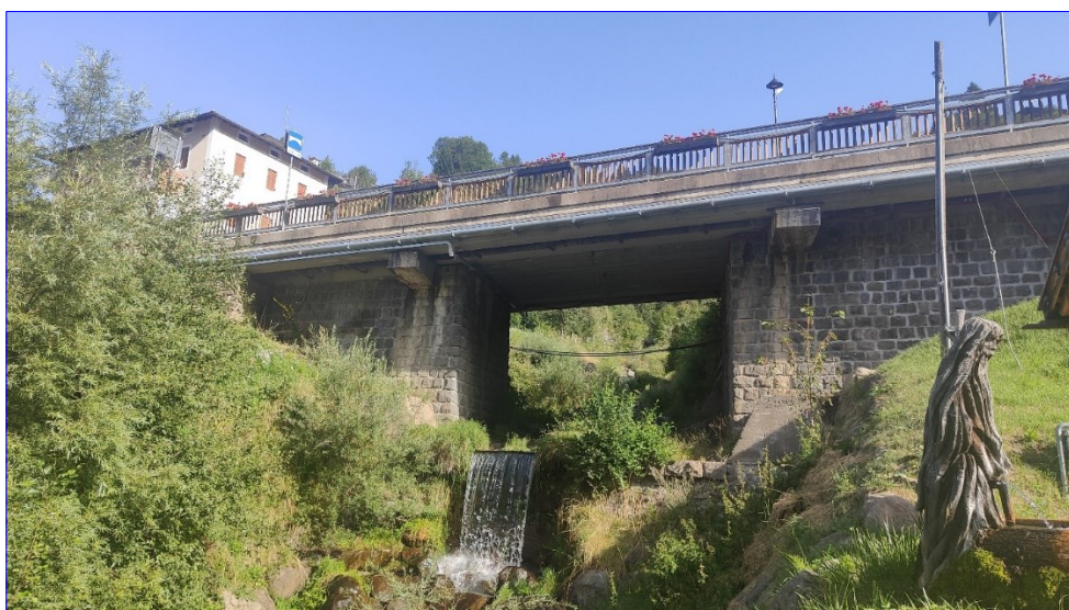
Foto 6: cunettone posto al di sotto dell'attraversamento con strada comunale.
