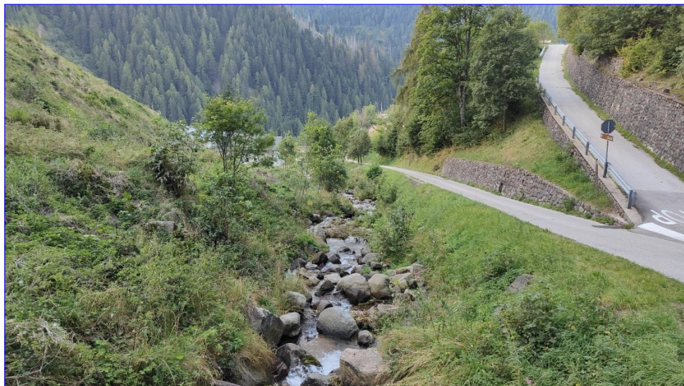
Foto 7: tratto sistemato Rio Val dei Lenzi (subito a monte dell'abitato di Palù).
