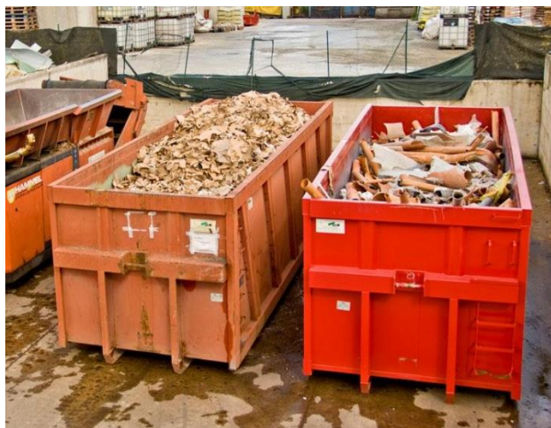
Figura 4.1: Esempi di uno stoccaggio dei rifiuti corretto (sinistra) e scorretto (destra)
