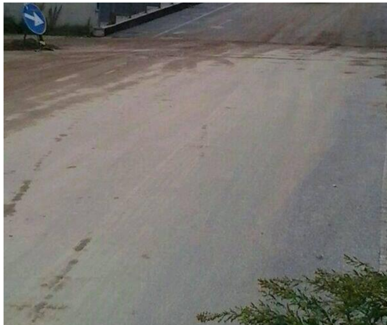
Figura 5.1: Strada di accesso a un cantiere imbrattata
