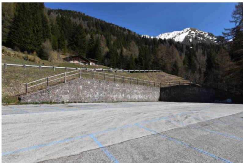
Fotografia stato di fatto parcheggio
