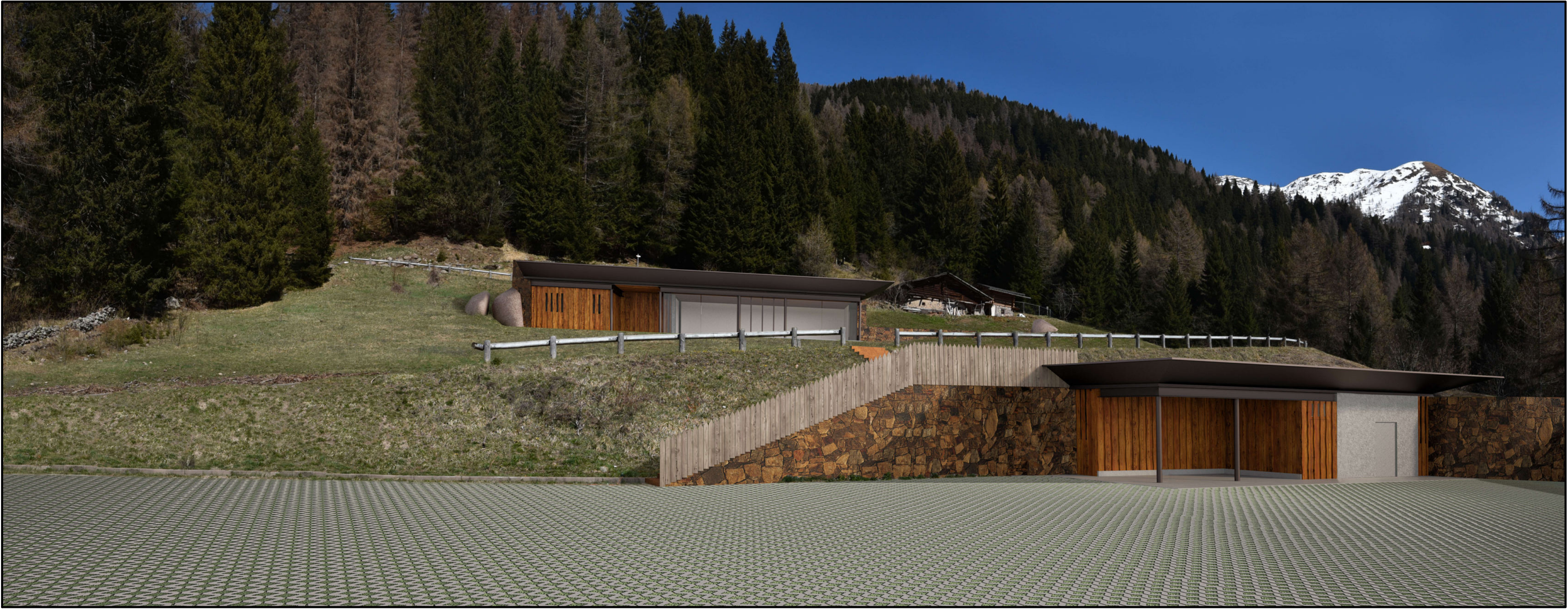
VISTA GENERALE CON L'EDIFICIO 1 E L'EDIFICIO 2 DAL PIAZZALE DEL PARCHEGGIO
