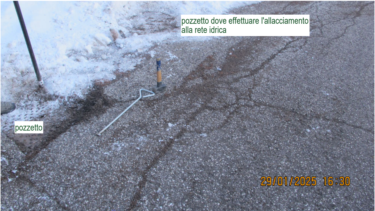
foto 5- dettaglio del pozzetto rete idrica
