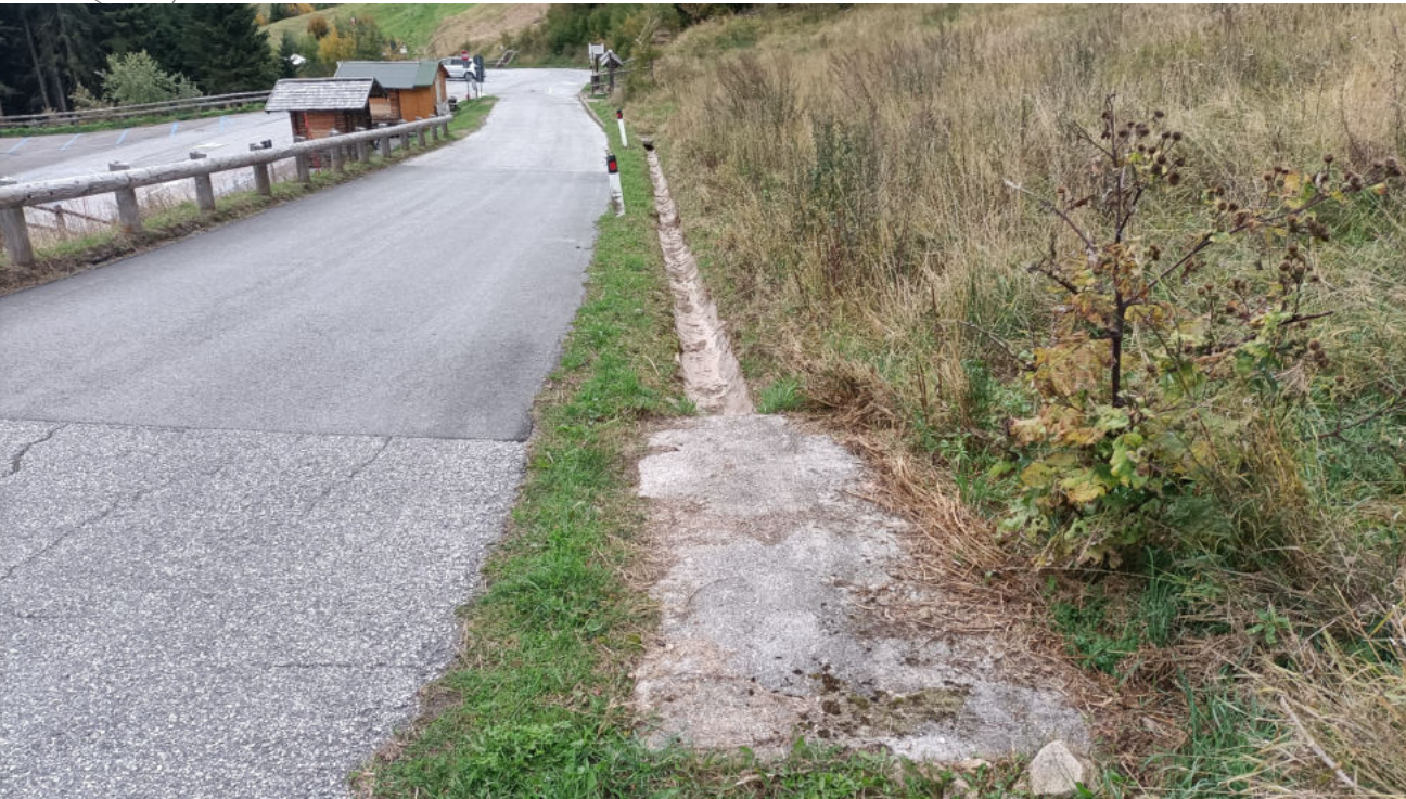
foto 3 - dettaglio della canalina esistente di raccolta acque superficiali
