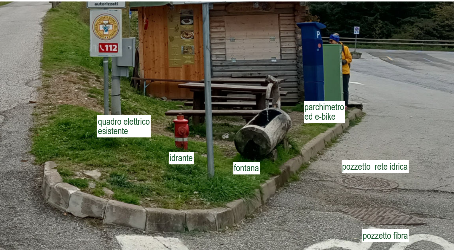
foto 2 - dettaglio zona dove insiste il pozzetto rete idrica
