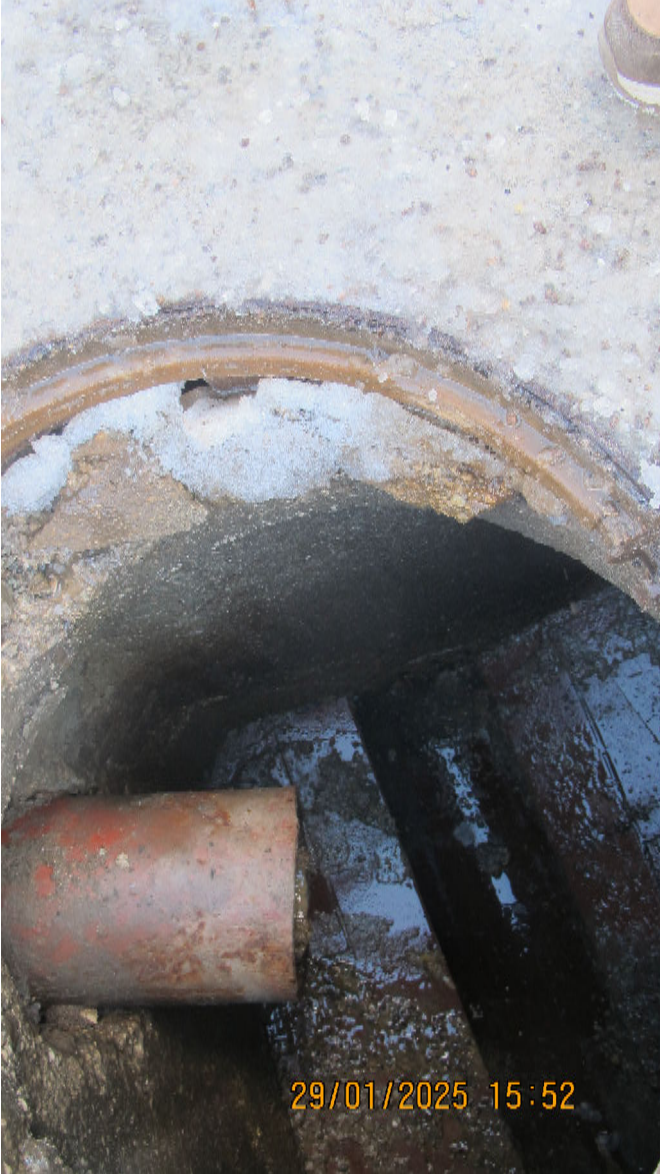
foto 1- pozzetto di partenza linea acque nere
