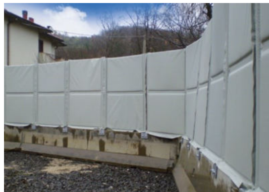
pannelli fonoassorbenti sulle delimitazioni di cantiere
