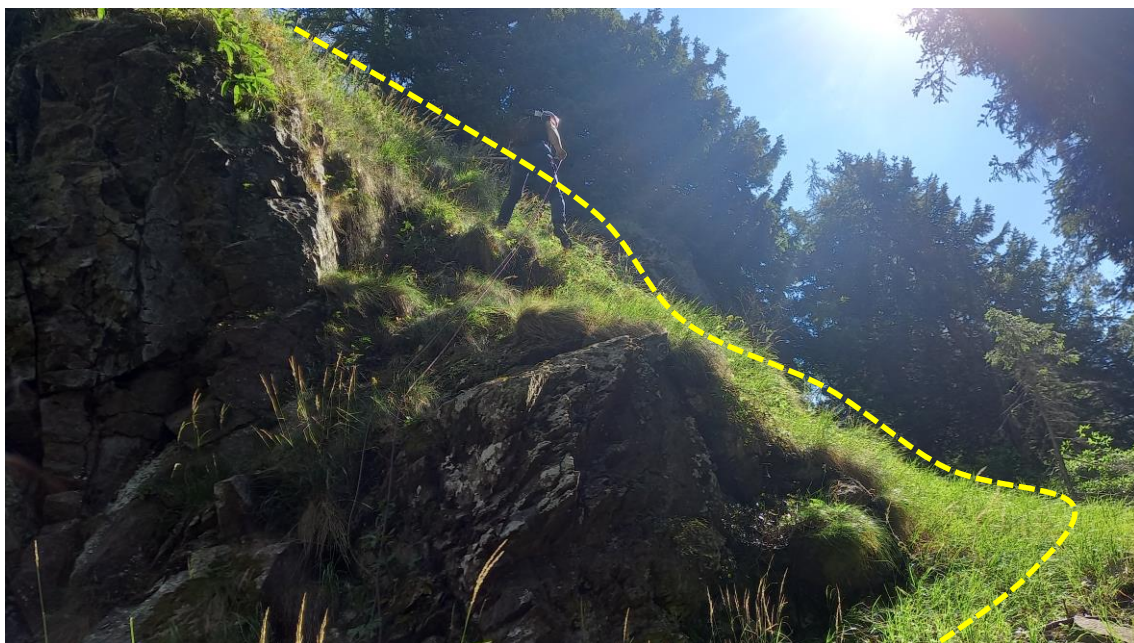
foto 3 – tratto intermedio, in fase di ispezione
