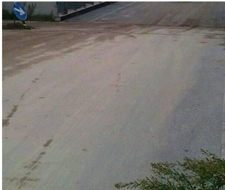
Figura 5.1: Strada di accesso a un cantiere imbrattata
