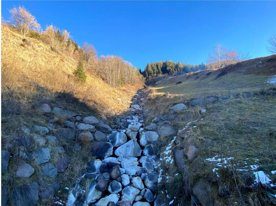
Fig. 15: vista verso monte dal attraversamento (progressiva 85 ml). Si osservano le opere eseguite dalla PAT, costituite da scogliere in massi ciclopici.
