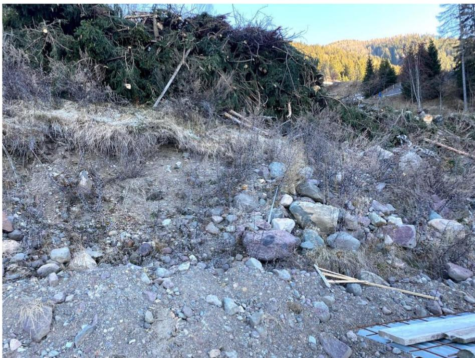
Fig. 42: sezione trasversale 1 poco a monte dell’area di progetto (30-40 ml), nel tratto caratterizzato da minori pendenze e altezze delle sponde del rio (condizioni di maggiore criticità per fenomeni da colata).
