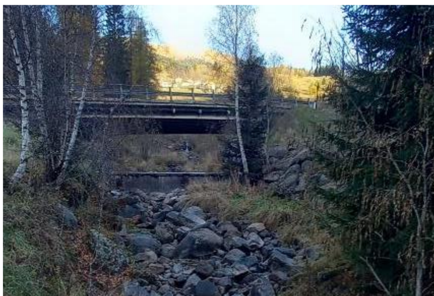
Figura 4.12: F9 – secondo attraversamento sulla SP135.
