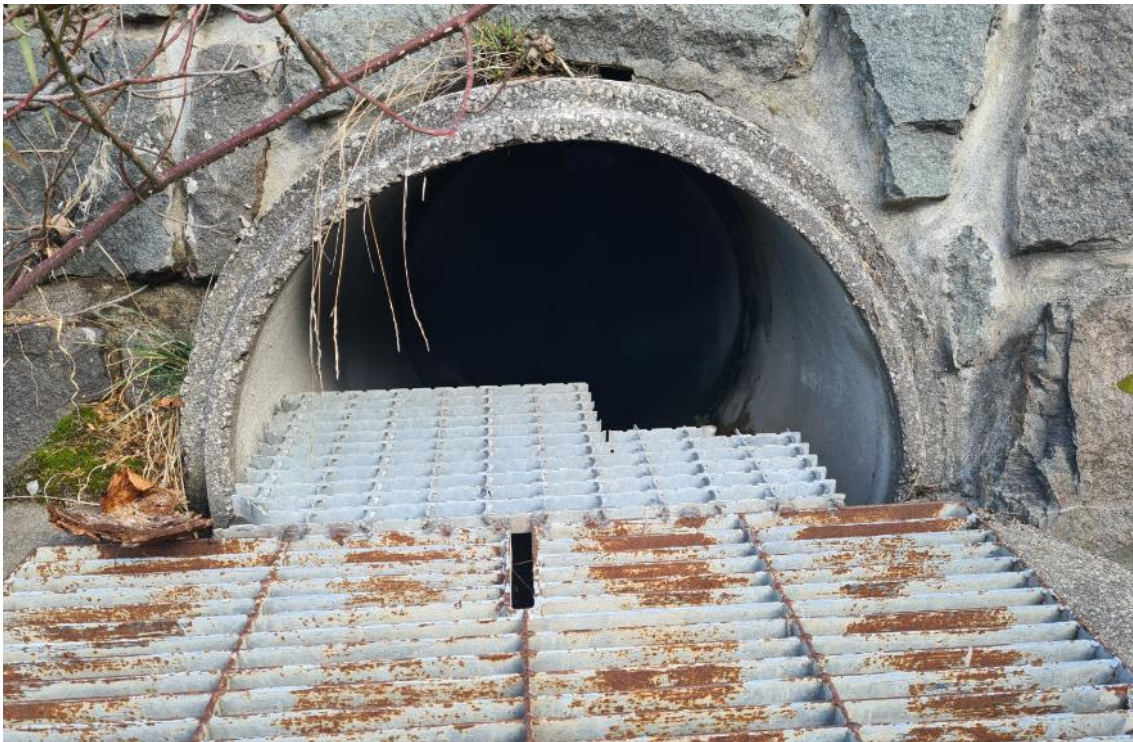
Figura 4.10: F8 – Vista della condotta interrata DN600 dell’attraversamento stradale del rio il cui bacino è delimitato in blu.
