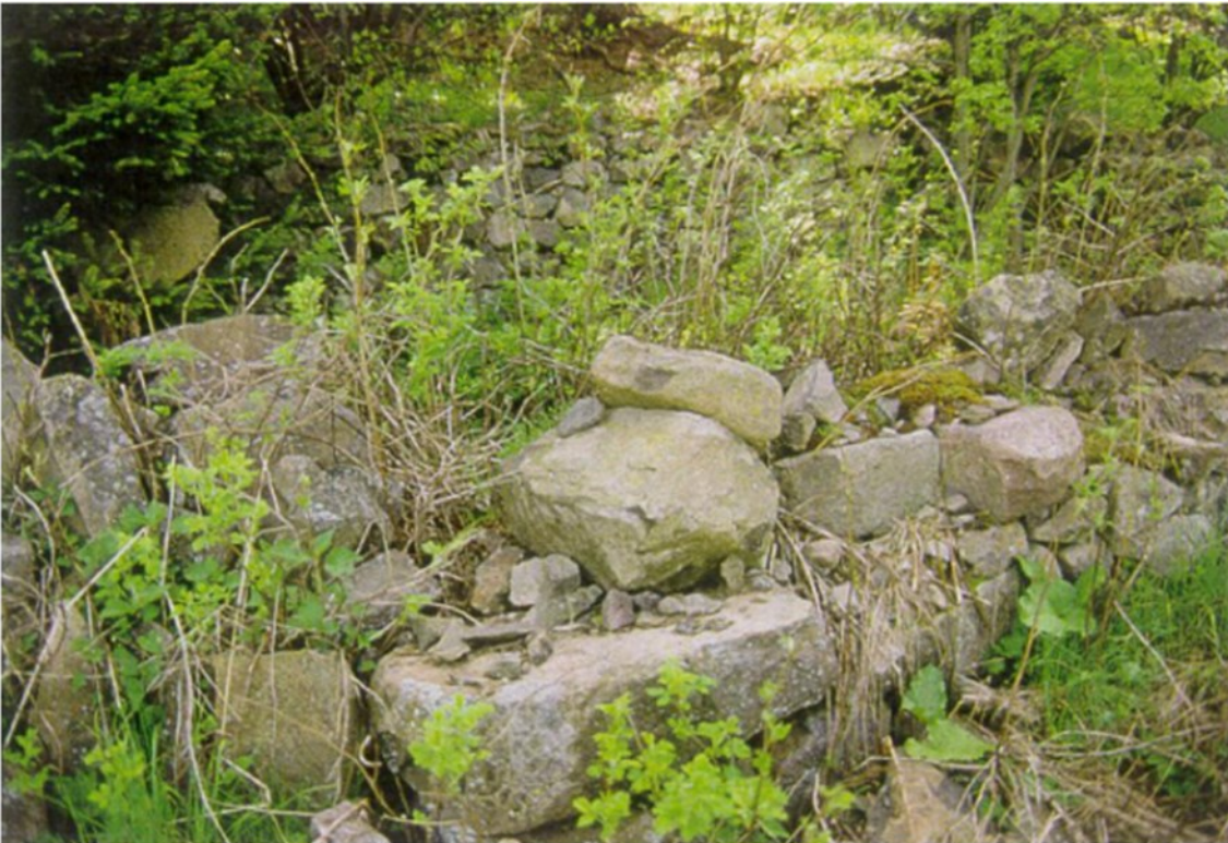
Figura 4: vista della p.ed. .514 da nord ovest
