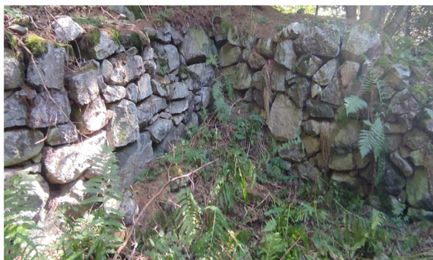
Vista ravvicinata della muratura a monte
