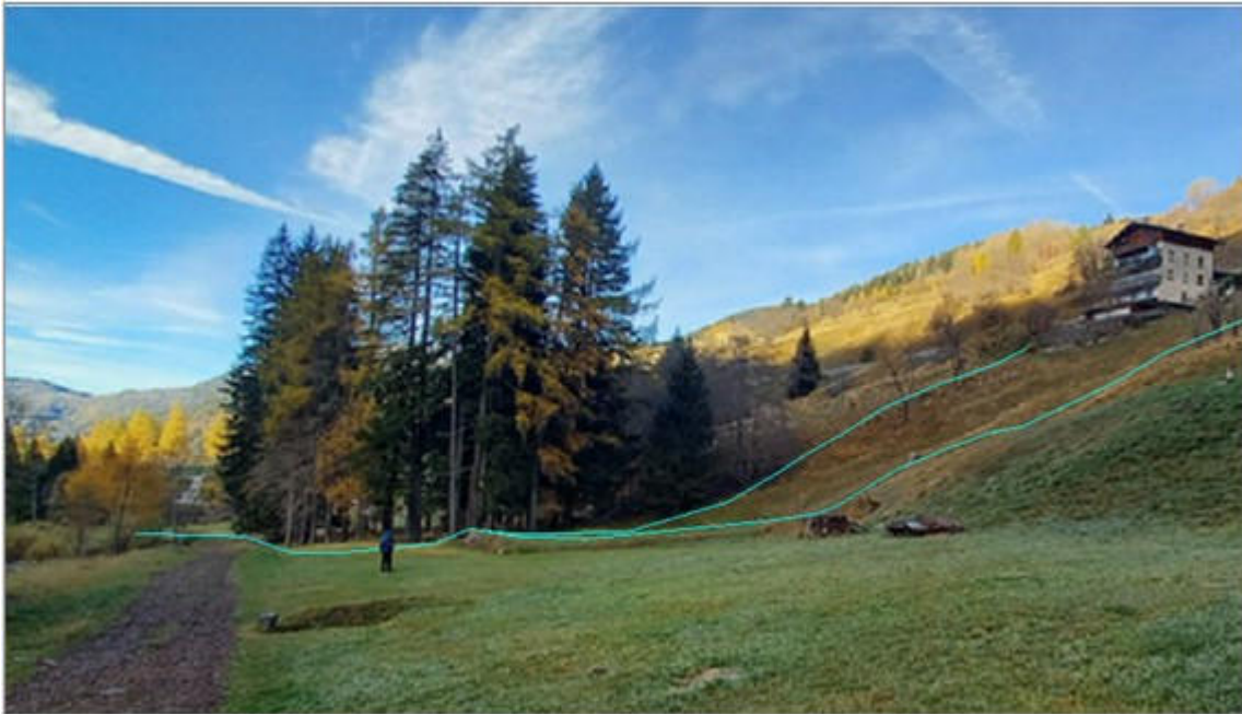
Figura 3.4: F1 – Parte bassa dei bacini imbriferi, in cui è prevista la variante al PRG.
