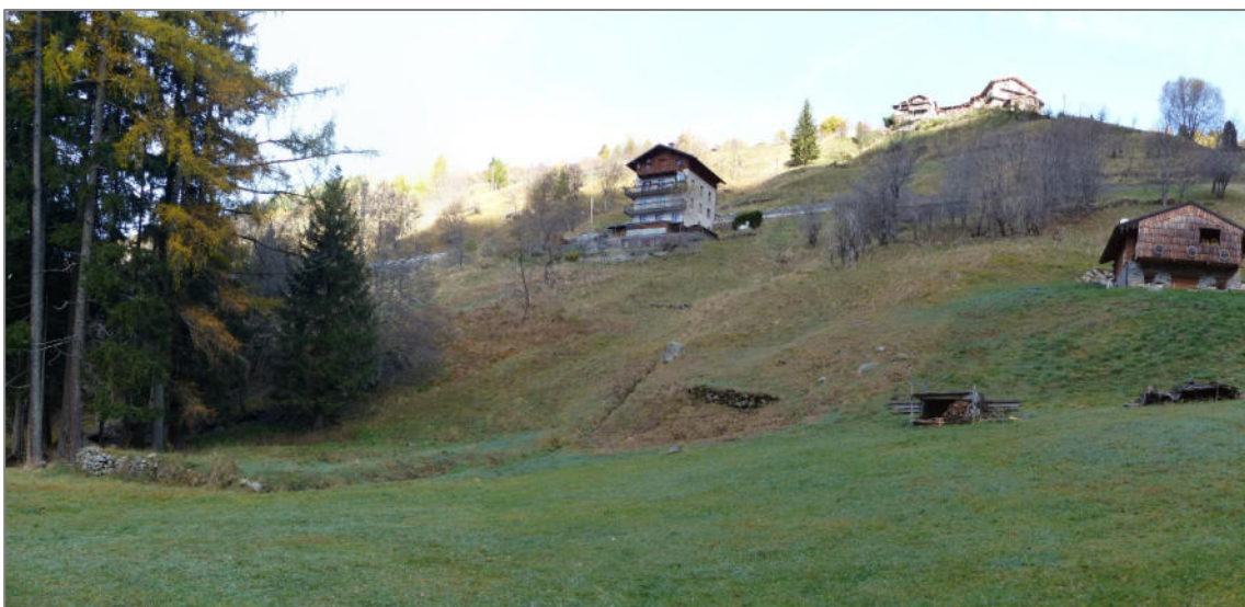
Foto 6.2: Panoramica dal fondovalle dell'area oggetto di variante e del versante a tergo classificato nella CSP a potenziale coinvolgimento con fenomeni torrentizi e di frana.
