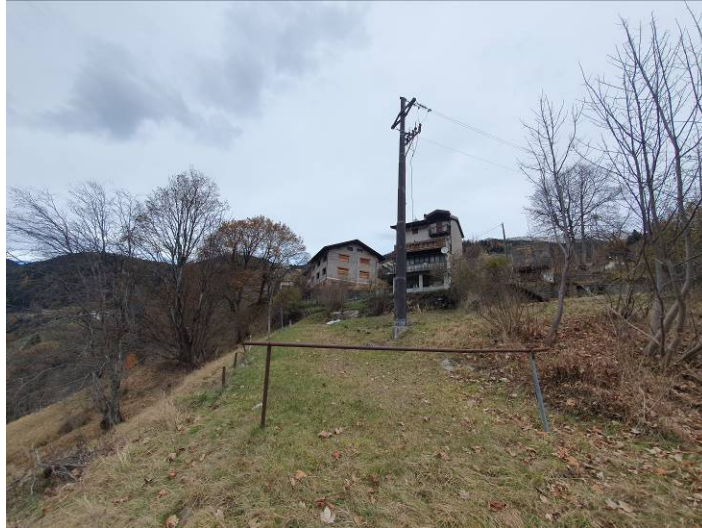
Foto 1. Palone della linea aerea di media tensione (punto 7) dal quale eseguire lo stacco del tronco 7-8 dove si prevede la posa del cavidotto
