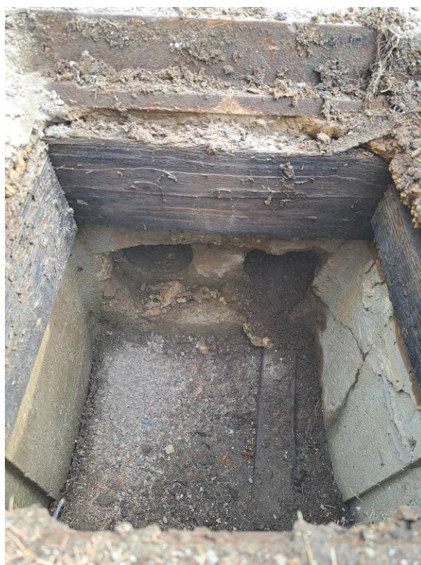
Foto 37. Pozzetto in destra rio Battisti collegato al pozzetto in sinistra rio, idoneo per l'attraversamento del rio stesso senza la necessità di procedere con nuove opere
