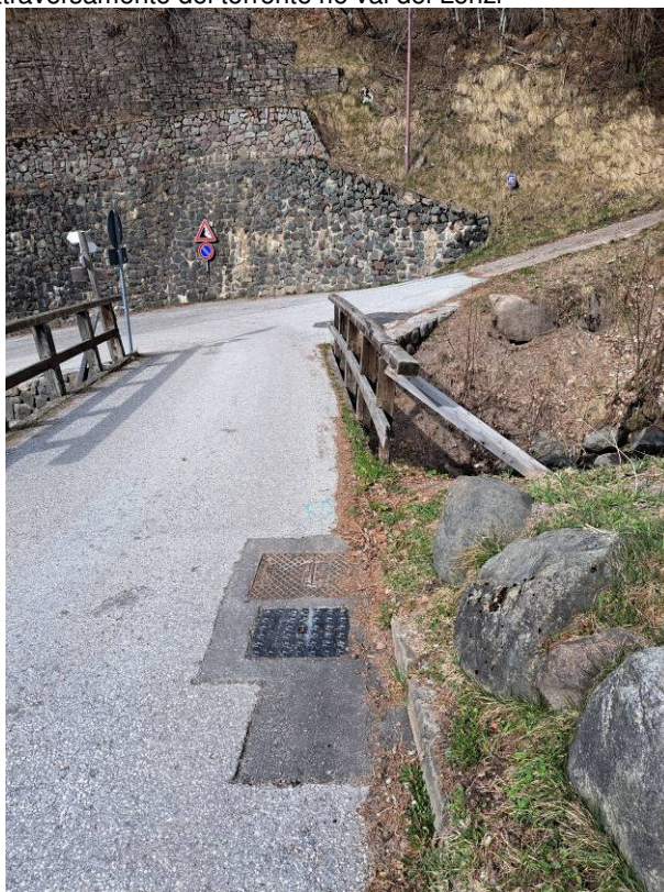
Foto 17. Vista verso valle dove è presente il pozzetto in sinistra rio con i cavidotti necessari per l'attraversamento del torrente rio val dei Lenzi
