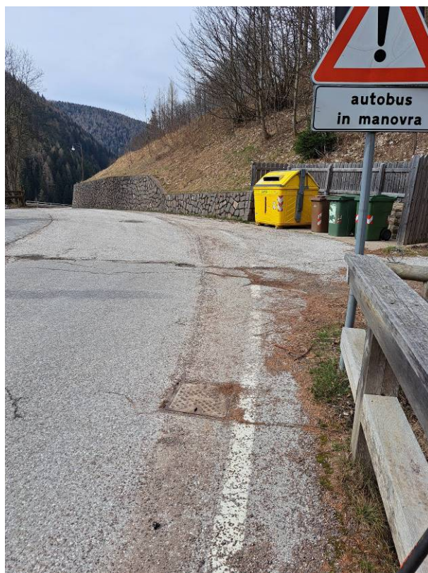
Foto 36. Pozzetto in destra rio Battisti nel quale terminerà il nuovo cavidotto posato tra le posizioni 10-1
